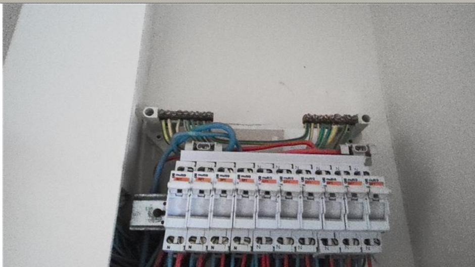
Description : Le courant assigné (calibre) de la protection contre les surcharges et courts-circuits d'au moins un CIRCUIT n'est pas adapté à la section des CONDUCTEURS correspondants.
