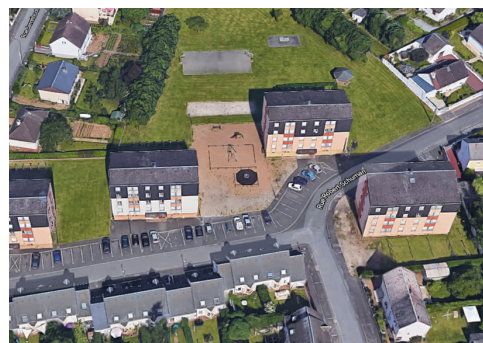
Projet déconstruction "Les Petits Millions"
