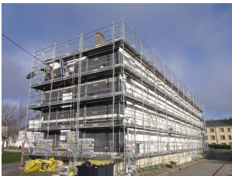
Réhabilitation thermique : Gravier/Tesson
